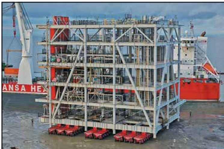
Рис. 3. Блочно-модульный метод строительства
